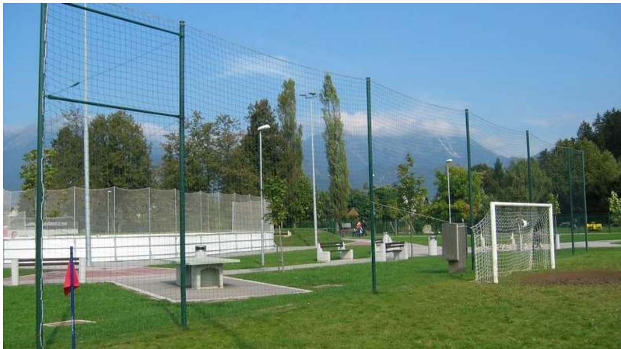
Slika 7 primjer zaštitne mreže sa stupovima
