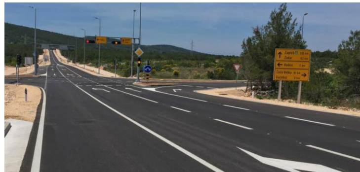
Slika: Izgradnja zaobilaznice grada Vodica – 2 faza
