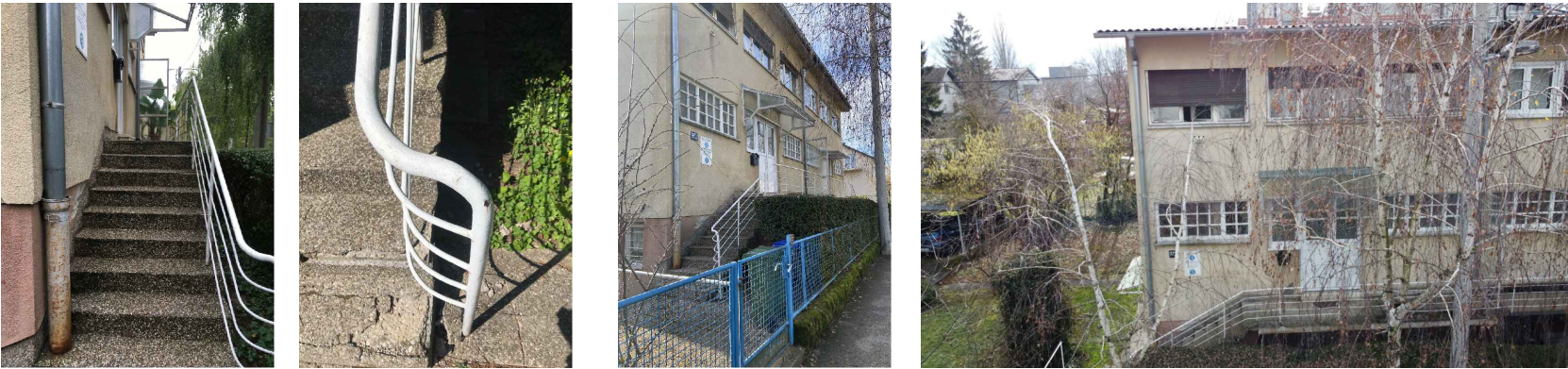
fotografije postojećeg stanja
