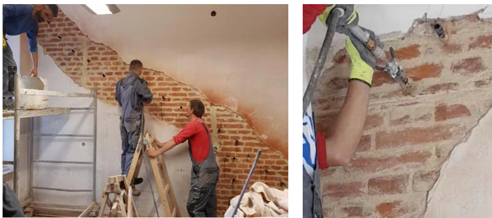
Prikaz postupka injektiranja zidova
