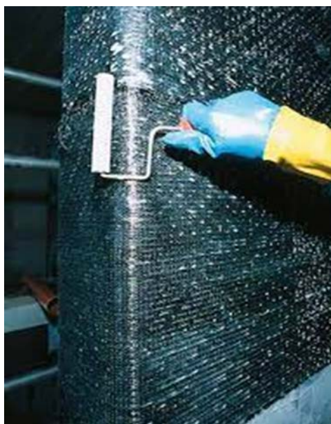
Prikaz postupka ojačavanja elementa pomoću MapeWrap G UNI-AX
