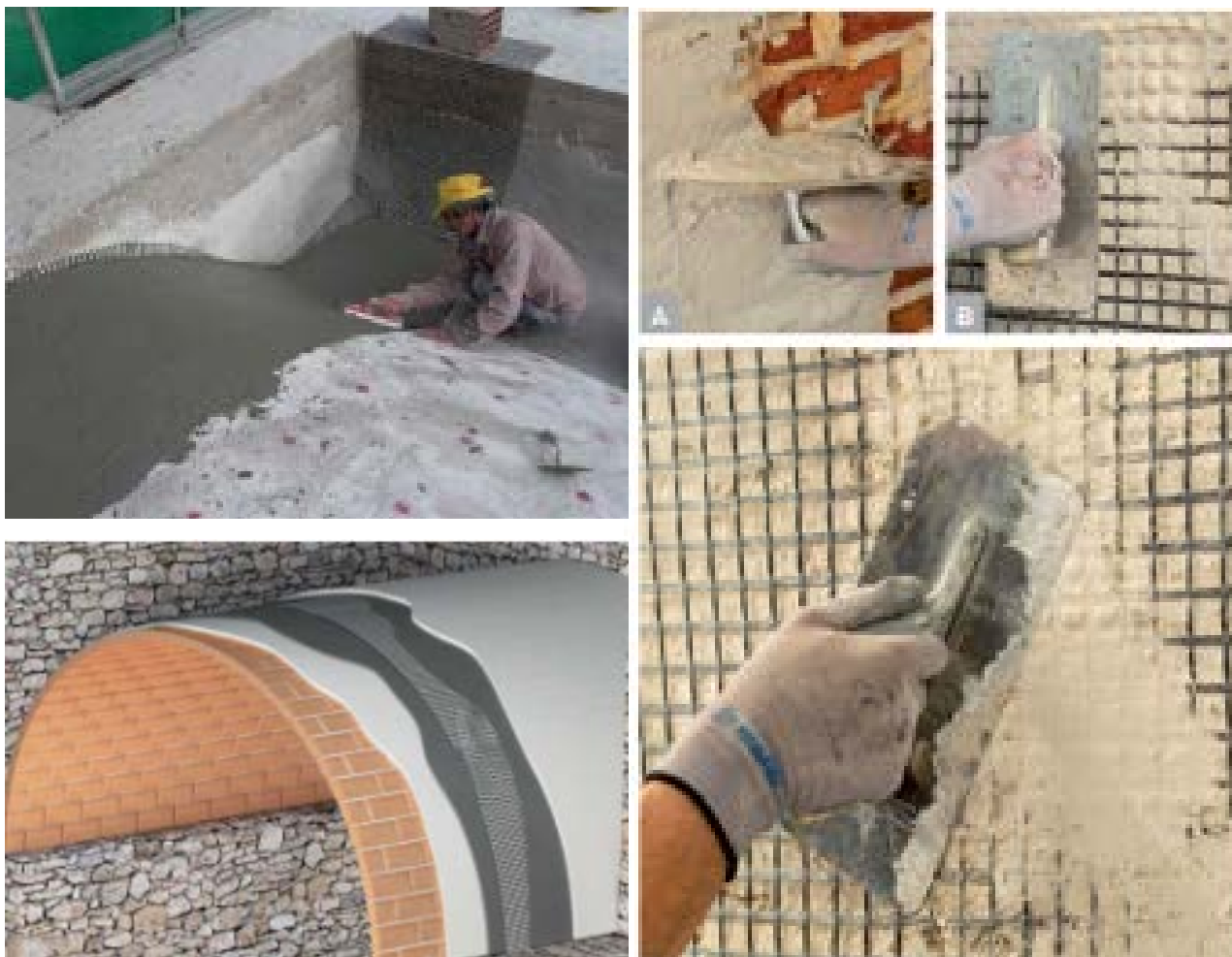
Prikaz postupka izvedbe FRCM-a na svodovima
