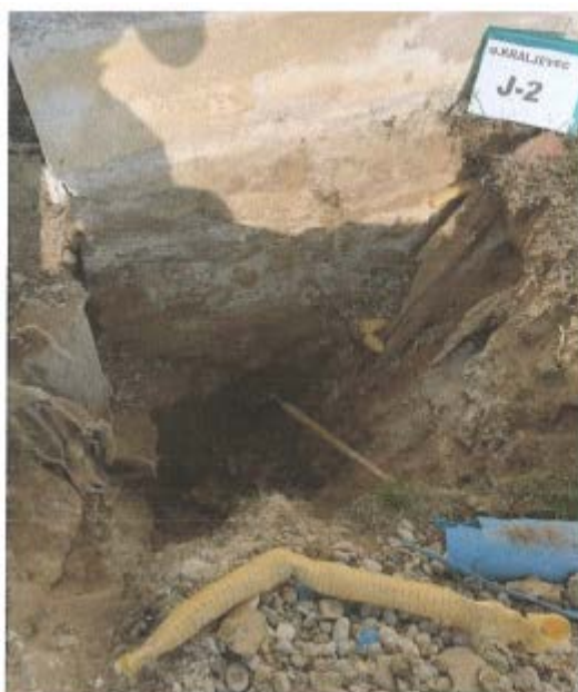
Položaj iskopa i sondi za ispitivanje temelja
