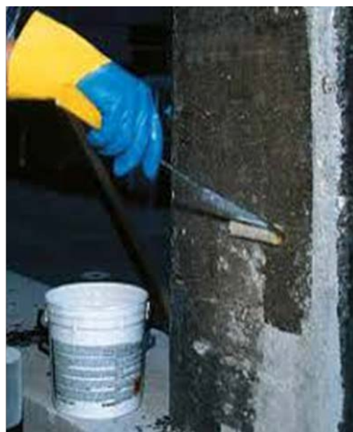
Prikaz postupka ojačavanja elementa pomoću MapeWrap G UNI-AX
