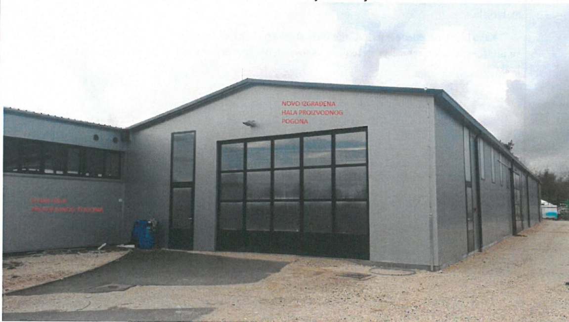
Slika 2. Novo izgrađena hala proizvodnog pogona
