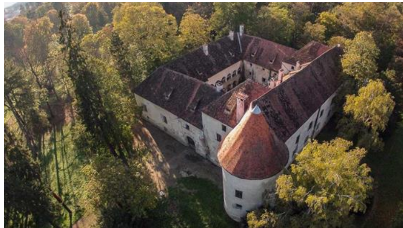
Obnova Dvorca Erdödy u tijeku
